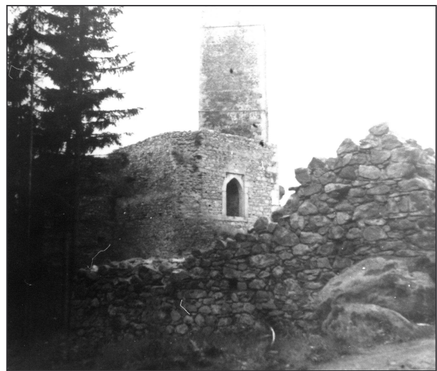
Detail v místě napojení zdiva na skalní výchoz.
