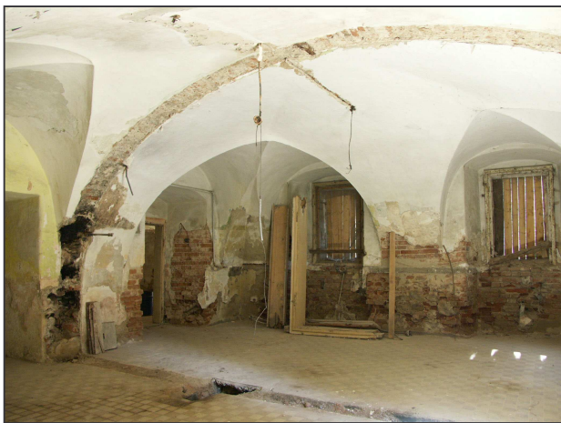
Týnec, starý zámek, přízemí, místnost č. 6 s raně barokní klenbou, pohled k severovýchodu (foto J. Anderle 2005).
