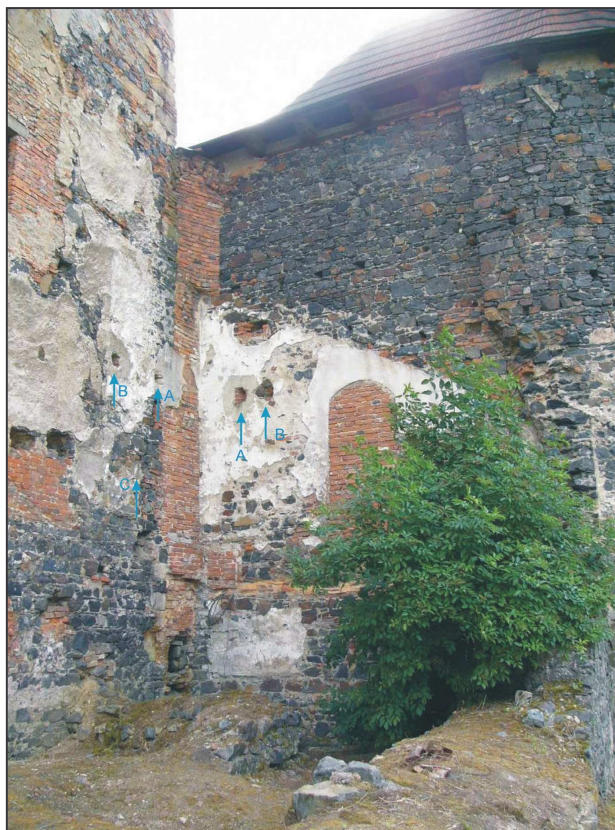
Švihov. Pohled na východní stranu Červené bašty a severozápadní nároží severního paláce. Šipkami vyznačena trámová výměna – kapsy A-A, kapsy B-B a místo odřeznutého stropního trámu C (foto 2005).
