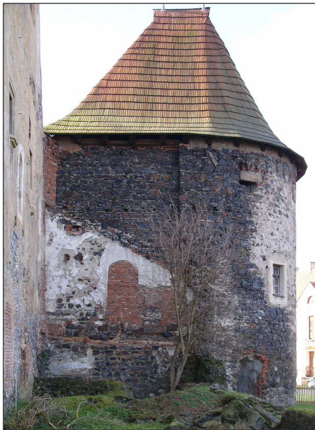
Švihov. Červená bašta. Pohled od východu (foto 2010).
