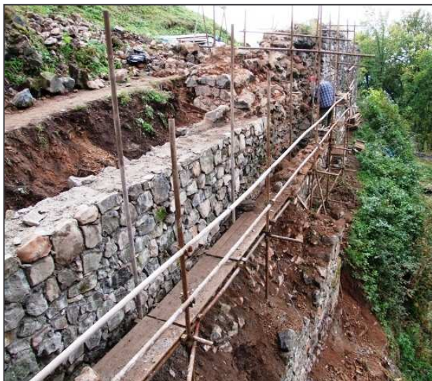
Kumburk – oprava okružní hradby u Studniční věže.
