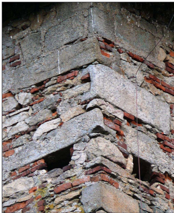
Kamenné žlabby druhotně použité jako armatury pod korunu severozápadního nároží Thurnovského paláce.
