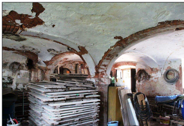
Čistá, přízemí západního křídla (foto O. Slabý 2013).
