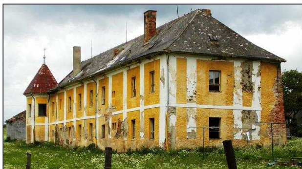
Zámeček Gutštejn-Daňkov od jihovýchodu.
