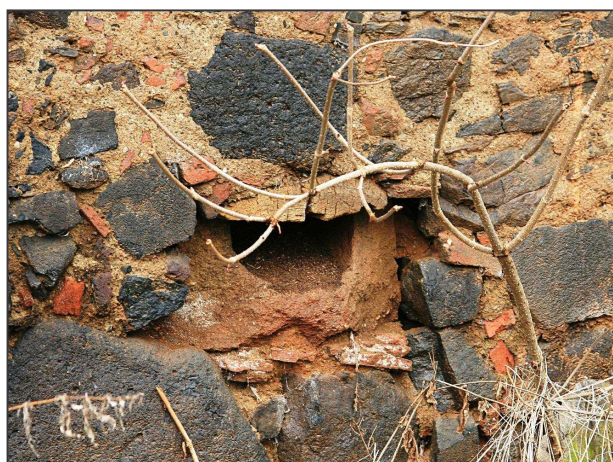
Obr. 6: Týniště, odtokový žlab – výlevka ve zdivu jižního křídla dvora (foto L. Krčmář 2008).
