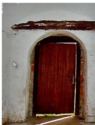
Zleva: Dubový překlad z valdštejské přestavby datovaný do let 1420-1437. Záděný gotický průchod, dendrochronologicky vrocený do let 1421-1433 (foto J. Pešta 2011).
