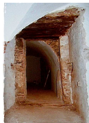
Zleva: Dubový překlad z valdštejské přestavby datovaný do let 1420-1437. Záděný gotický průchod, dendrochronologicky vrocený do let 1421-1433 (foto J. Pešta 2011).
