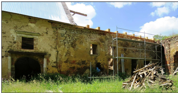
Toužimský zámek v rekonstrukci.
