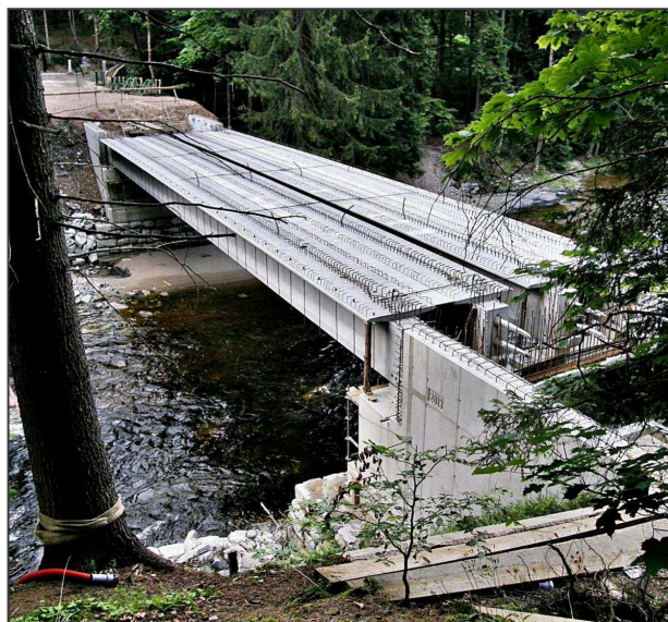
Snímek rozestavěného mostu pod hradem demonstruje výšku nad hladinou řeky (foto autor 2013).
