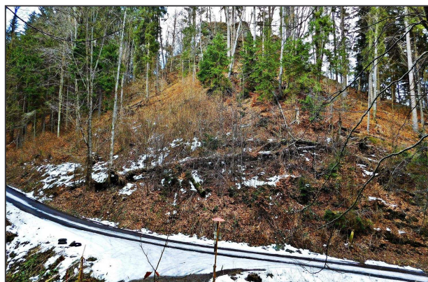
Jižní strana nístejského paláce s dobře patrnou cestou pod ním z r. 1902 (foto autor 2016).
