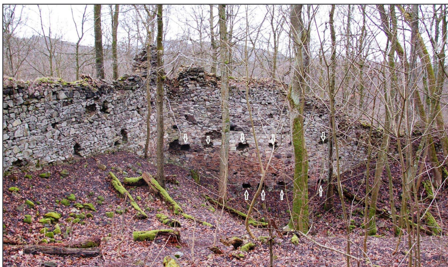
Otvory pro osazení stropních trámů dvoupodlažního objektu, vylámané do jihovýchodní nádvoří části obvodové hradby (označeno šipkami), který byl k této hradbě přiložen počátkem 16. stol. Pohled od jižní stěny donjonu.
