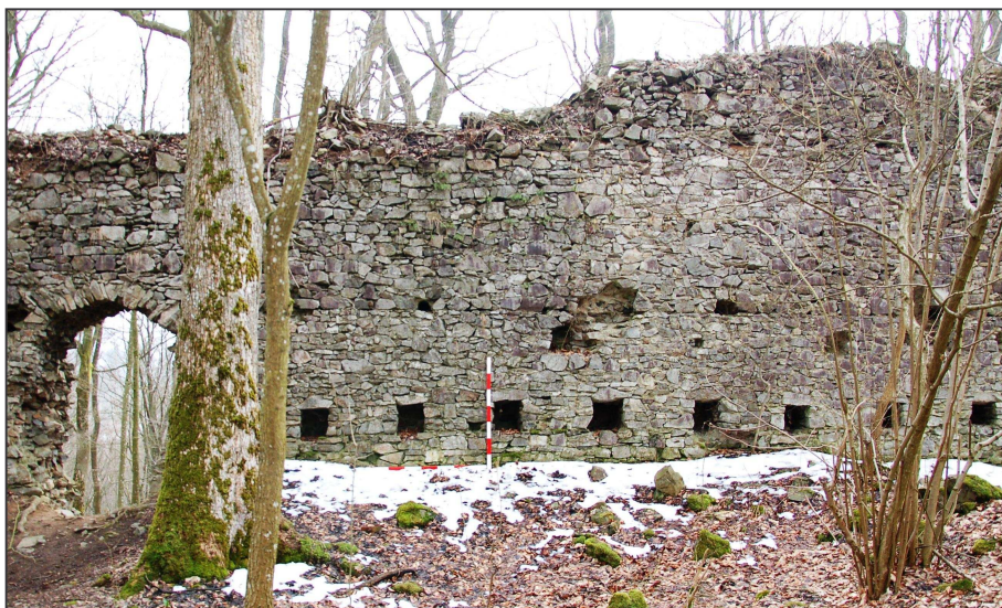
Detail stavebního provedení trámových kapes v nádvoří části jihozápadní obvodové hradby. Tyto otvory byly připraveny při výstavbě obvodové hradby v polovině 14. stol. a trámy do nich byly osazeny později v rámci výstavby hospodářského objektu, přiloženého k této části obvodové hradby. Jeden dílek latě je 0,2 m.
