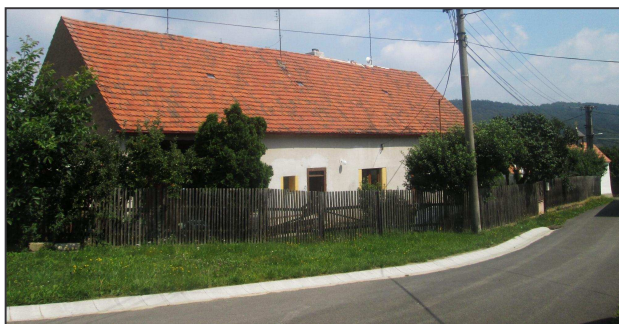
Jihozápadní průčelí domu čp. 1 ve Lhotce v místě zámku, vpravo v pozadí kaplička (foto autor 2016).
