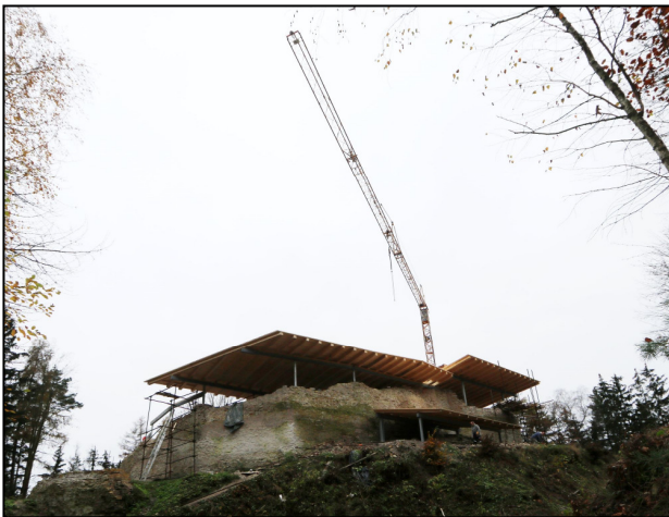
Momentální dominantou hradu Vízmburka je velký stavební jeřáb, kromě stavby nových střech probíhá i konzervace zdiva.
