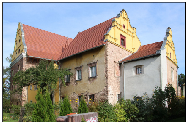
Tvrz ve Střední Stěnavě vznikla poměrně složitým stavebním vývojem, nejstarší částí je blok paláce s ohrazením nádvoří.
