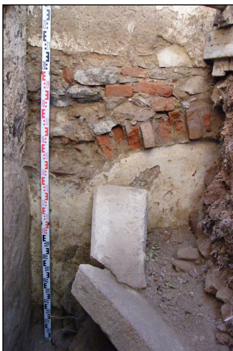
Obr. 6: Rýzmbek – situace odhalená sondou při nádvořní zdi tzv. starého paláce. K vidění je zde příčka patrně renesanční přístavby s interiérovou omítkou, zbytkem cihelné klenby, otiskem podlahy a přelomeným architektonickým článkem s jednoduchou profilací – pohled od severovýchodu (foto P. Kausek 2011).
