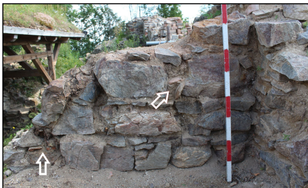
Obr. 5: Rýzmbek – jedna z příček tzv. starého paláce, která je přizděna na spáru k jihovýchodní obvodové zdi. Šipkami označeny zlomky prejzů použitých ve zdivu – pohled od jihozápadu (foto P. Kausek 2019).
