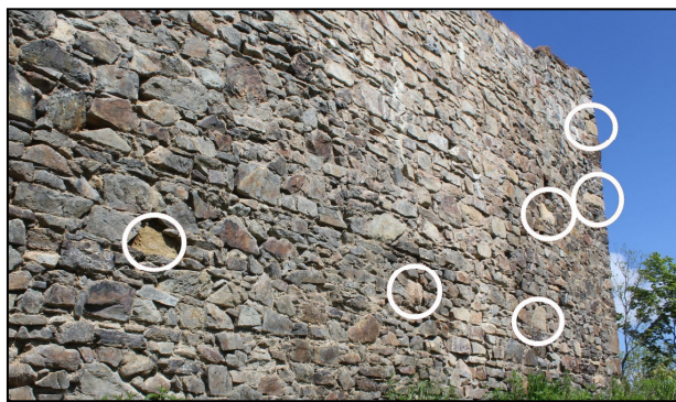
Obr. 3: Rýzmbek – vnější líc jihovýchodní zdi tzv. starého paláce s vyznačením druhotně použitých kamenických článků – pohled od jihu (foto P. Kausek 2021).
