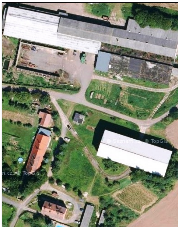
Letecký snímek prostoru bývalého poplužního dvora. Dole čp. 6, vlevo dole čp. 1 a 44 (citace v pozn. 33).
