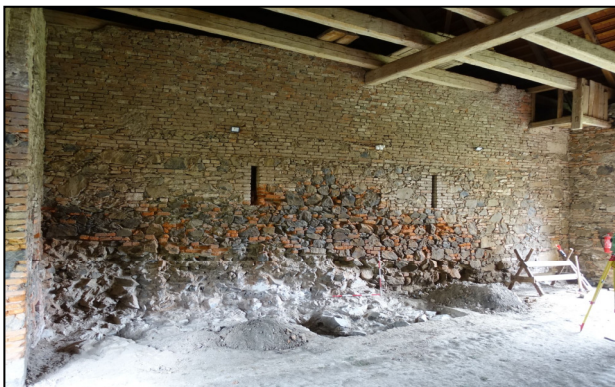
Obr. 2: Hrad Švihov – průjezd jižní stodoly. Zalomení zdi z doby kolem roku 1500, dochované při podlaze vlevo (foto autor, září 2025).
