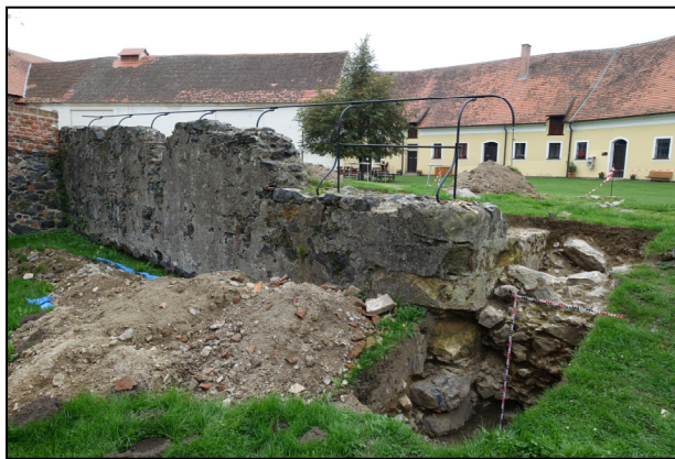
Obr. 5: Hrad Švihov – SV nároží budovy předbraní (foto autor, srpen 2025).
