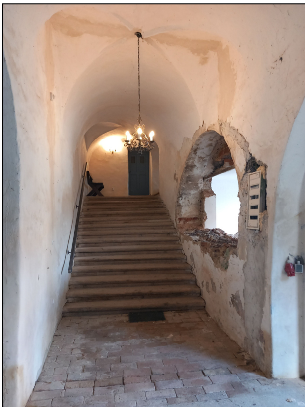
Odstraněná zazdívka arkády v zámku Běšiny.
