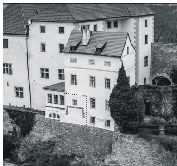
Obr. 6: Vysoký Chlumeček. Pohled na jižní křídlo. Patrná je odhalená původní brána. Čárkovaně vyznačena někdejší věžová brána (foto Tomáš Kopecký 2025).
